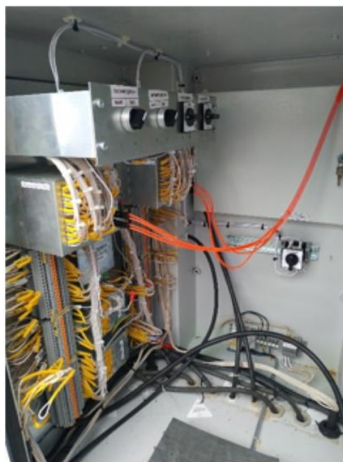
ПДС в шкафах привода выключателя В-110
